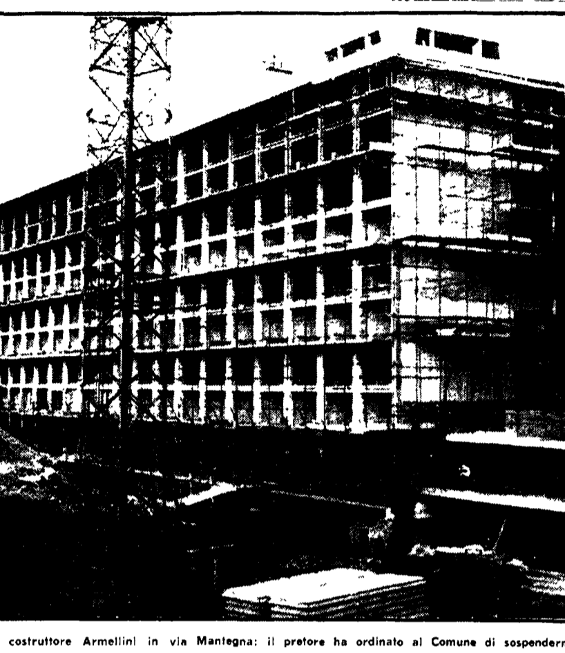
Uno dei palazzi abusivi del costruttore Armellini in via Mantegna: il pretore ha ordinato al Comune di sospendere la demolizione
