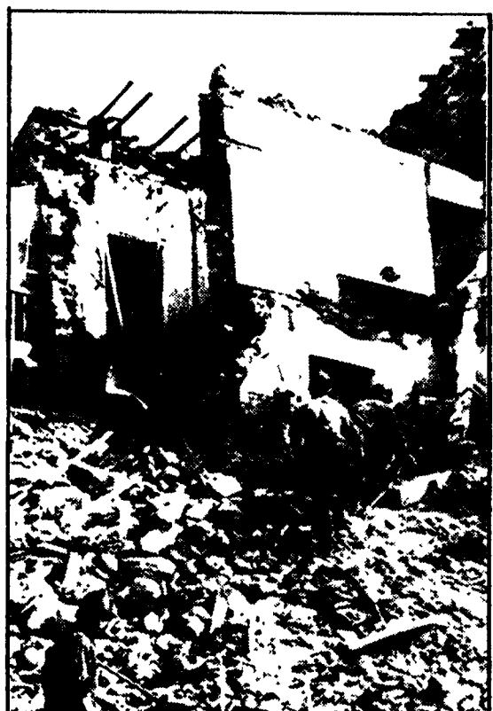
Il cumulo di macerie rimasto dopo il crollo della palazzina
