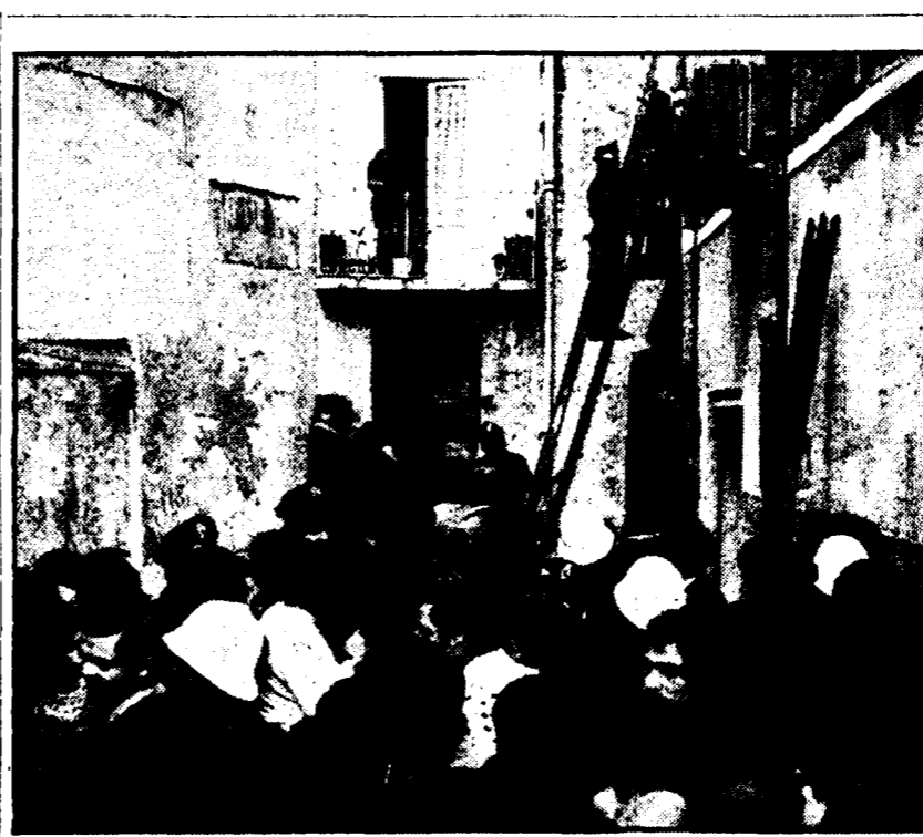
I funerali delle vittime di Taranto. Si sono svolti ieri a Taranto i funerali della persona perita nel crollo di un falliscente edificio nella città vecchia. In una riunione tenuta in prefettura i rappresentanti del PCI hanno chiesto la requisizione di alloggi sfitti per assicurare case stabili ai sinistrati. Nella foto: una folla segue il lavoro dei soccorritori nel punto dove lunedì è crollato l'edificio.
