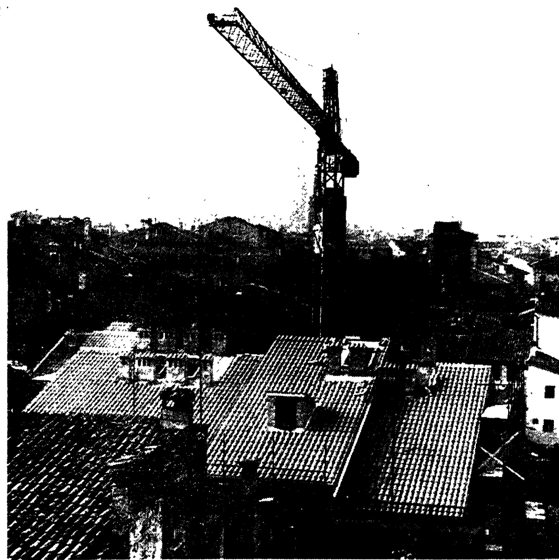
Lavori di risanamento nel centro storico a Bologna.
