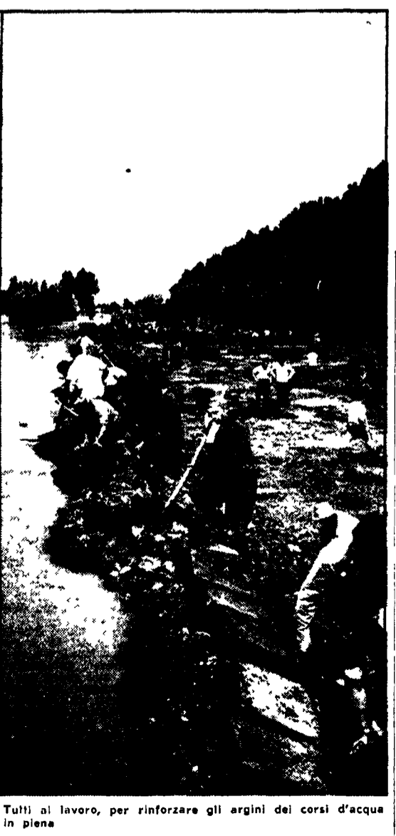
Tutti al lavoro, per rinforzare gli argini dei corsi d'acqua in piena
