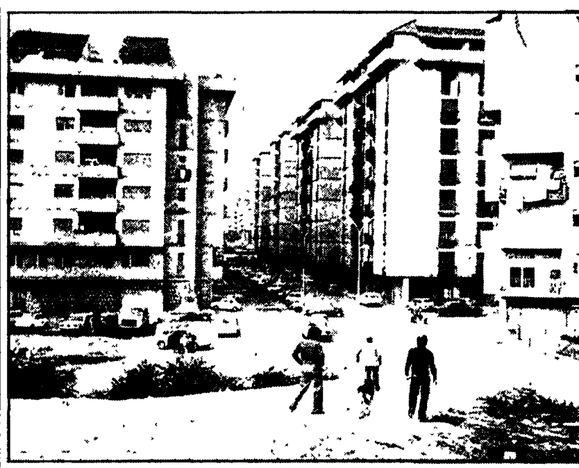
Palazzi della Magliana costruiti sotto il livello del Tevere
