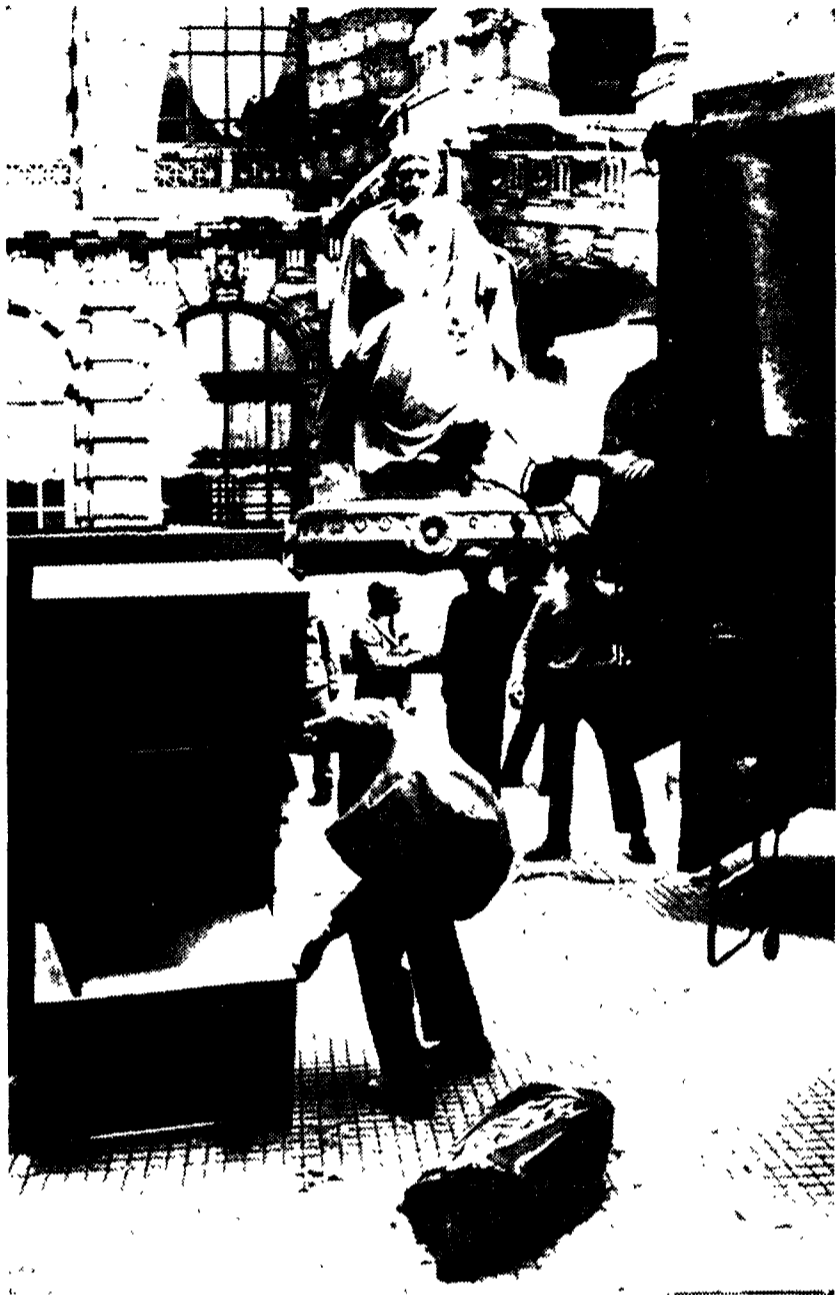
Un'immagine delle operazioni di sgombero del Palazzo di giustizia di Roma dichiarato qualche anno fa inagibile per l'instabilità dell'edificio.
