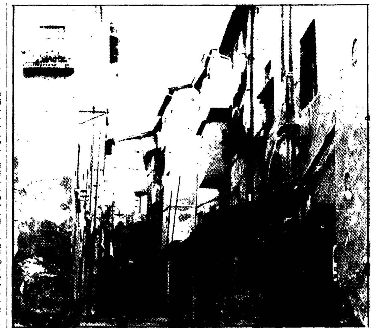
Una via del Centro storico di Lucca per la quale è indispensabile il risanamento
