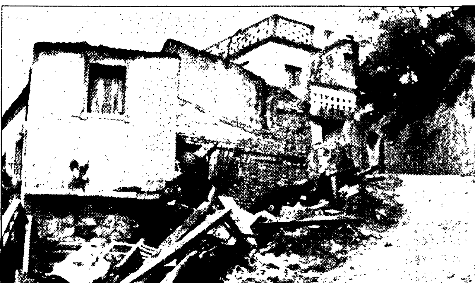
Un particolare dei gravi danni provocati dall'alluvione del '73 all'abitato di S. Luca. Ancora oggi si attendono provvedimenti per la sistemazione delle abitazioni lesionate
