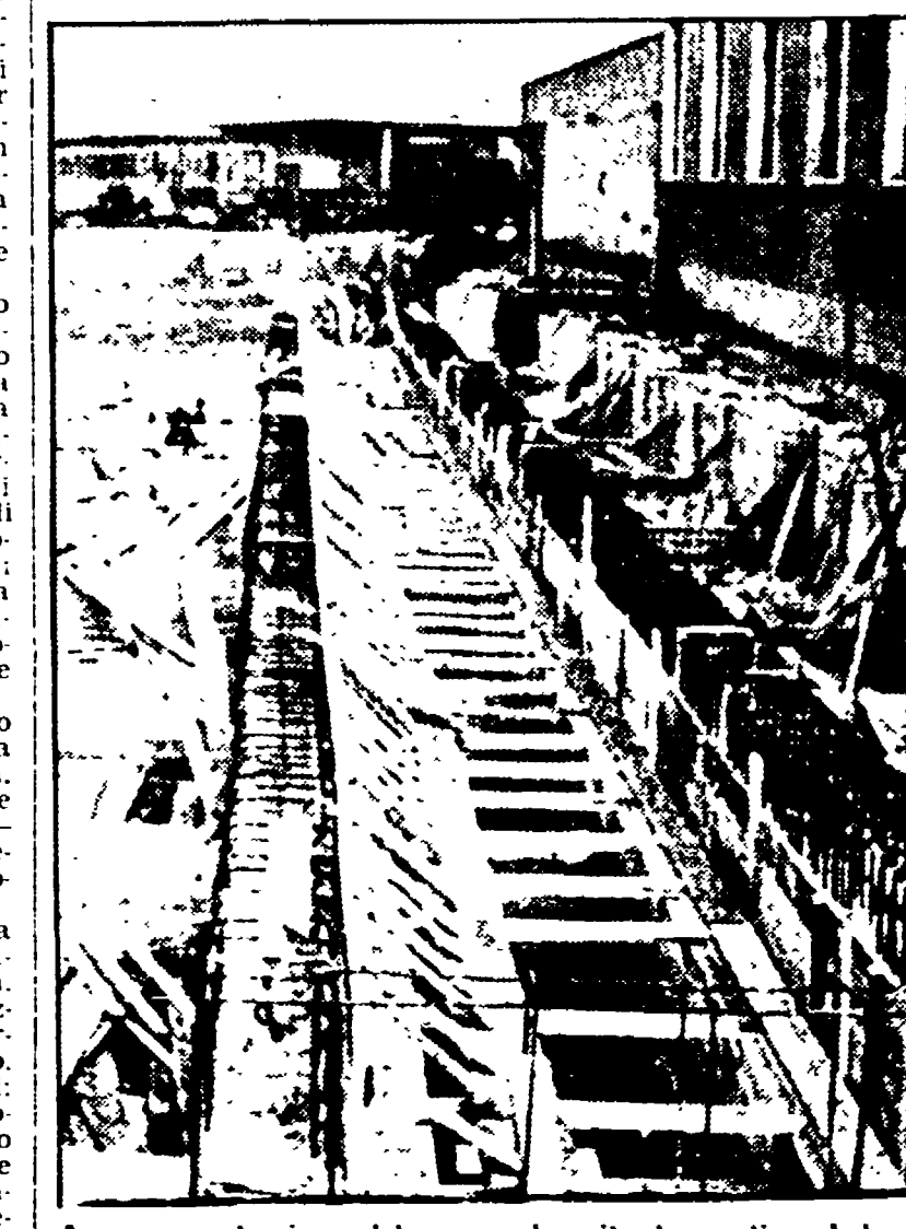
Ancona: costruzione del nuovo deposito locomotive. I lavori sono fermi da due mesi per mancanza di fondi
