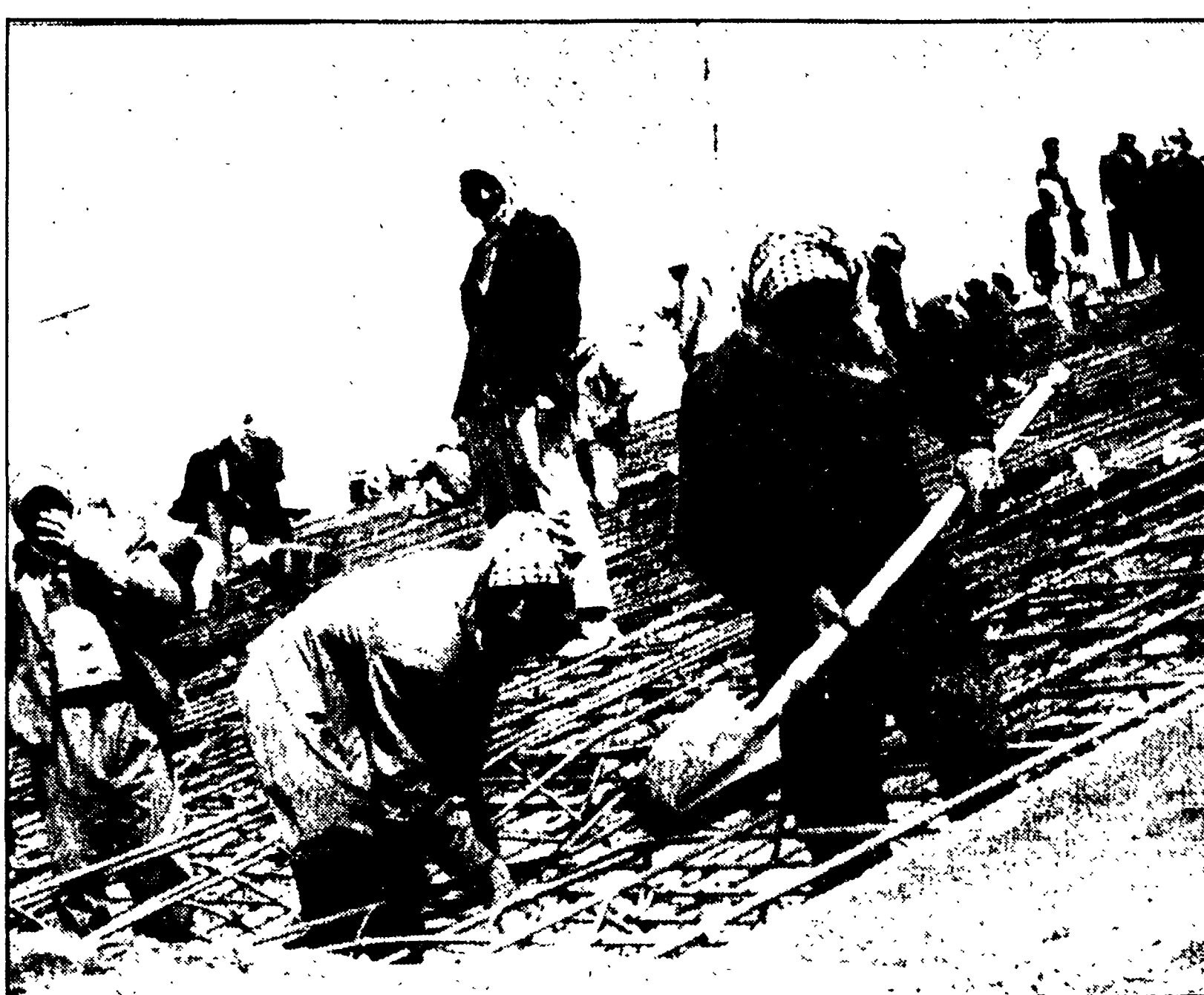
Lavori alle attrezzature idroelettriche della diga sull'Eufrate
