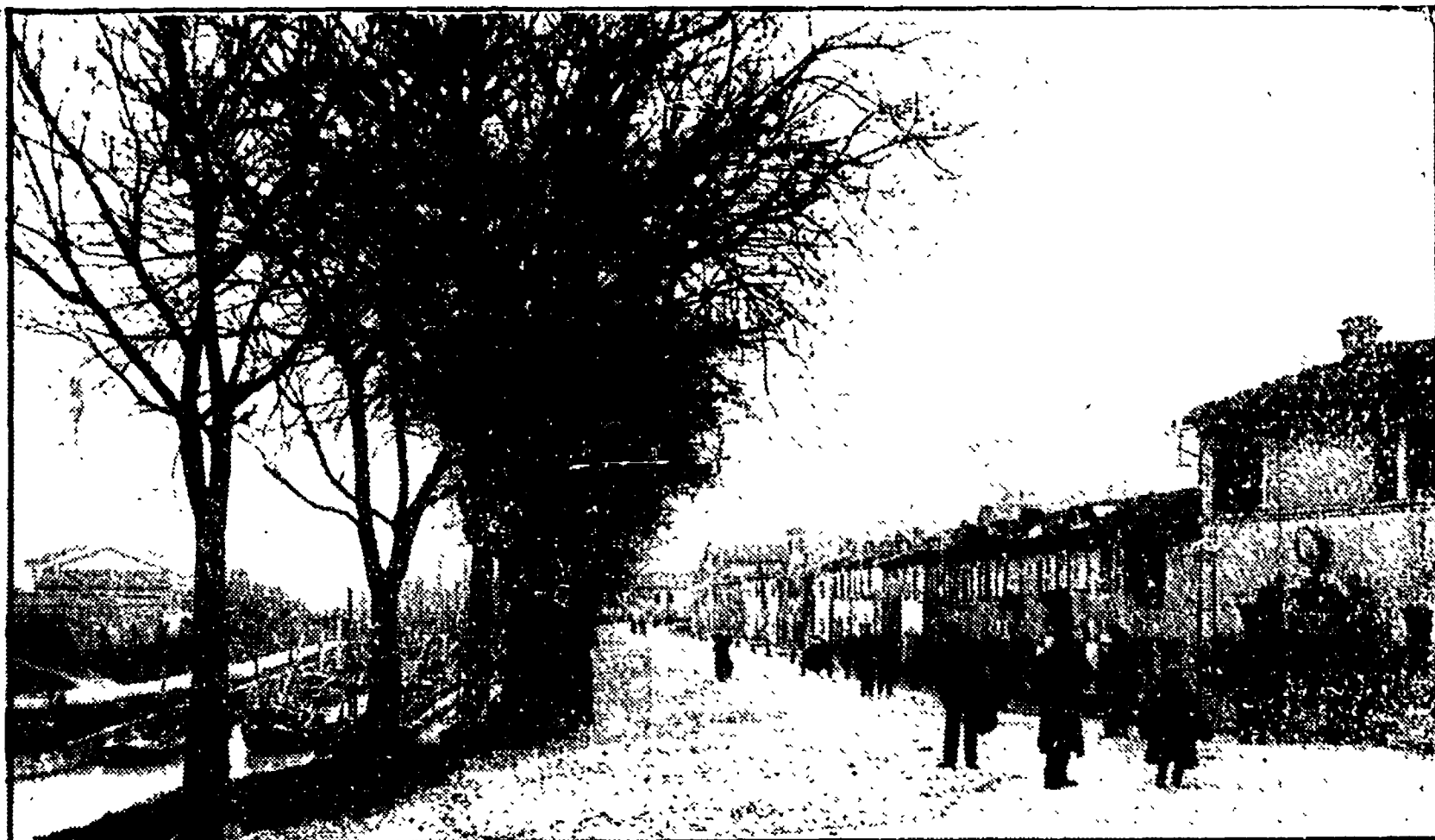
Via Nazario Sauro, di Fano, agli inizi del secolo. Il quartiere è stato «salvato» dalla variante al Piano regolatore
