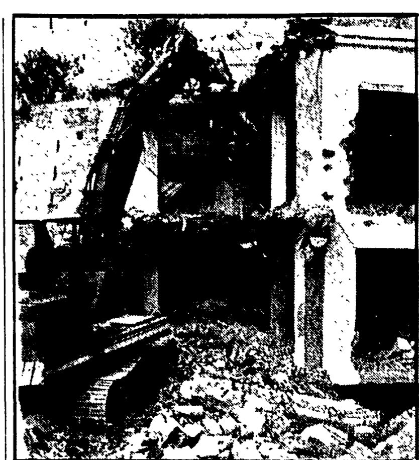
DEMOLIZIONE COMPIUTA La palazzina abusiva del costruttore Saggiocco in via Orazio è andata tutta giù e un altro vergognoso abuso edilizio è stato cancellato dall'azione del comune di Napoli in questo settore. Domani saranno portate via anche le macerie, e delle prelese di Saggiocco resterà al tribunale amministrativo, cui già il comune di Napoli ha presentato tutta la documentazione
