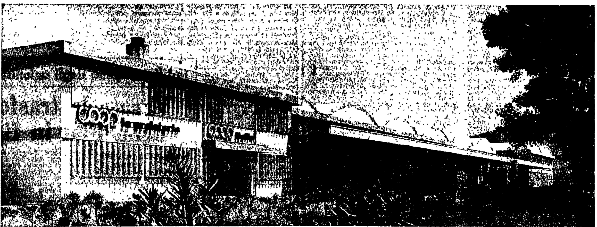
Vignale Riotoro (Piemonte): un'immagine del grande centro di distribuzione della Coop Italia e sede della Cooperativa «La proletaria». E' uno degli esempi che testimoniano l'intervento dell'UNIPOL a favore del mondo del lavoro.
