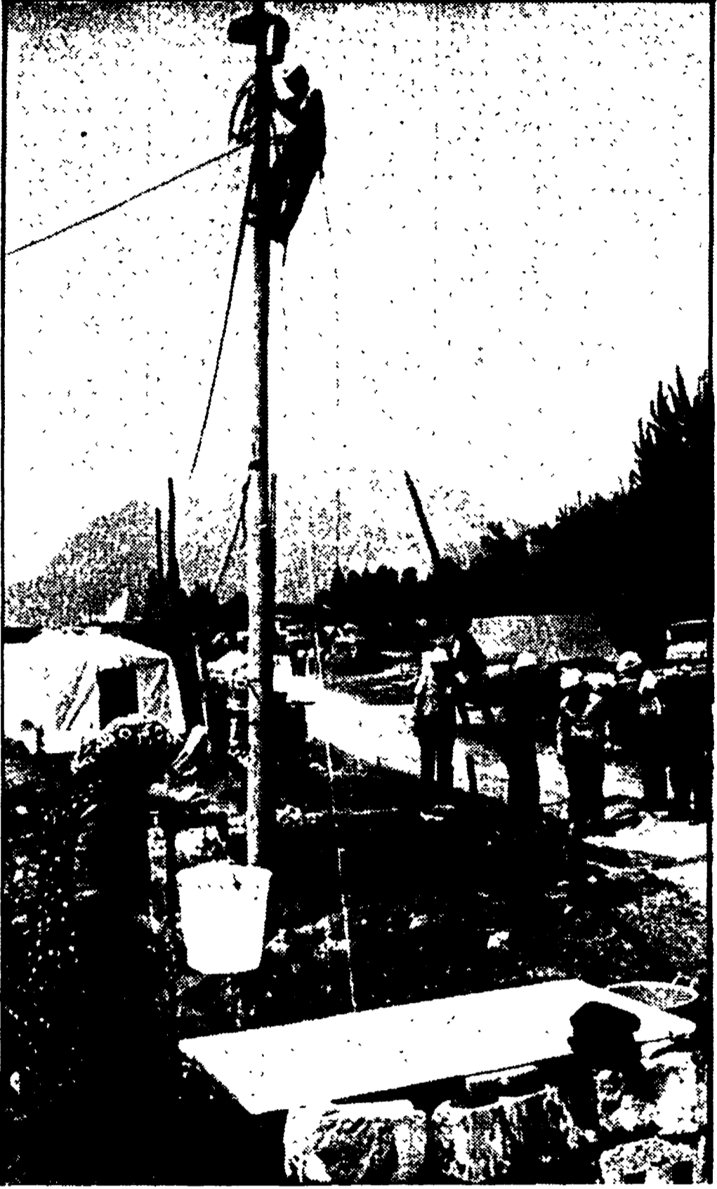
GDDO - Operai e tecnici al lavoro per ripristinare linee telefoniche e dell'alta tensione in una tendopoli presso Gemona
