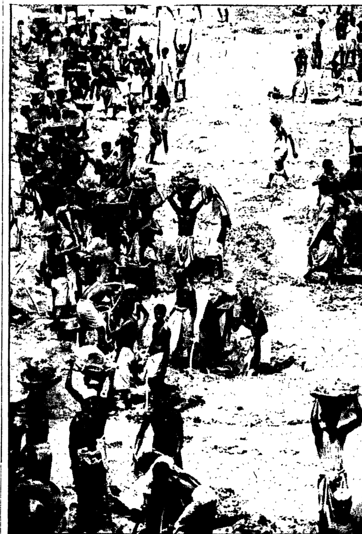
Migliaia di persone sono impegnate nel Bangladesh in opere di prevenzione delle alluvioni che flagellano periodicamente il paese. NELLA FOTO: la sponda destra del Brahmaputra affollata di uomini che compiono a mano lavori di sbancamento.
