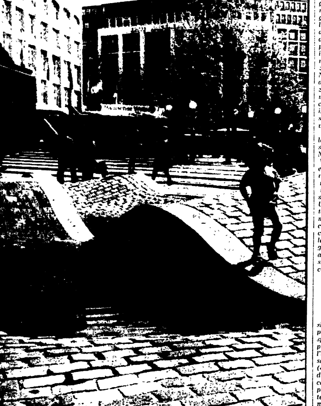
AMBURGO — Per realizzare un'isola pedonale gli amministratori comunali di Amburgo si sono chiesti perché mai la pavimentazione di una piazza debba essere necessariamente piastrellata. Hanno sottoposto il quesito ai tecnici i quali, per bloccare l'ingresso dei veicoli, hanno realizzato queste « onde pedonali ». Quando la pioggia è insistente si forma tuttavia un piccolo lago artificiale.
