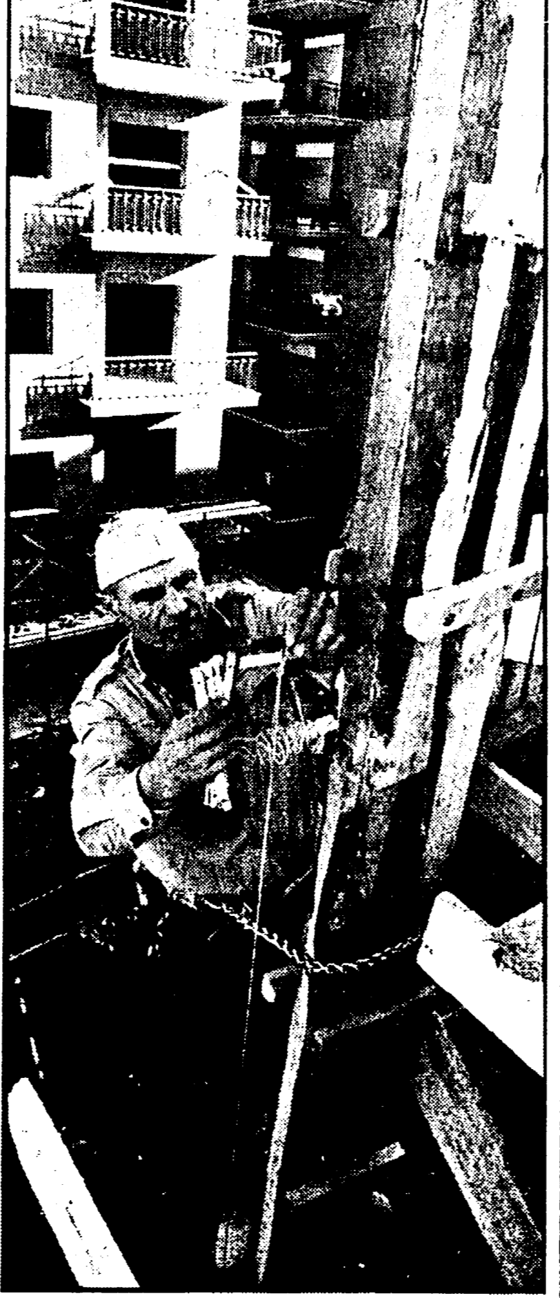
Edile al lavoro su un'impalcatura in un cantiere
