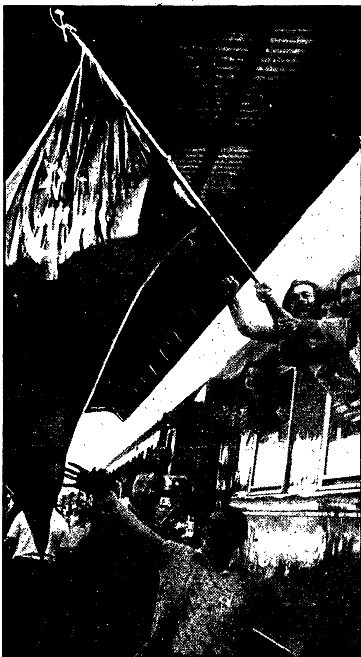
L'arrivo alla stazione di Campo di Marte di Firenze dei lavoratori emigrati all'estero che tornano in Italia, nei loro paesi d'origine per volare.
