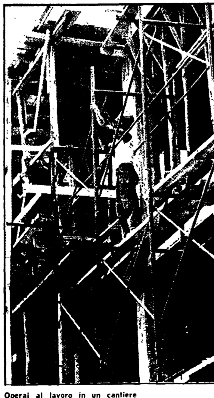
Operai al lavoro in un cantiere
