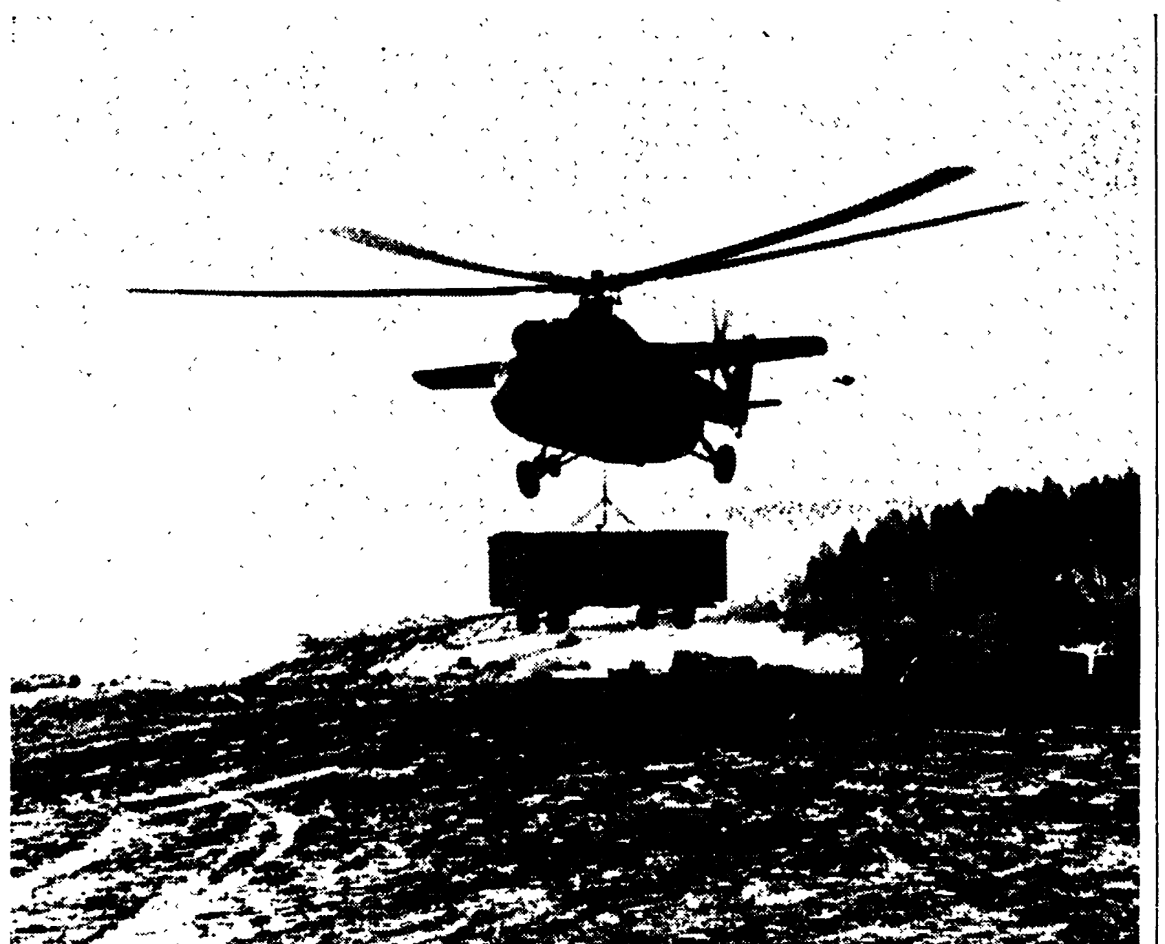
Un elicottero trasporta una delle «case» degli operai addetti alla costruzione della ferrovia.
