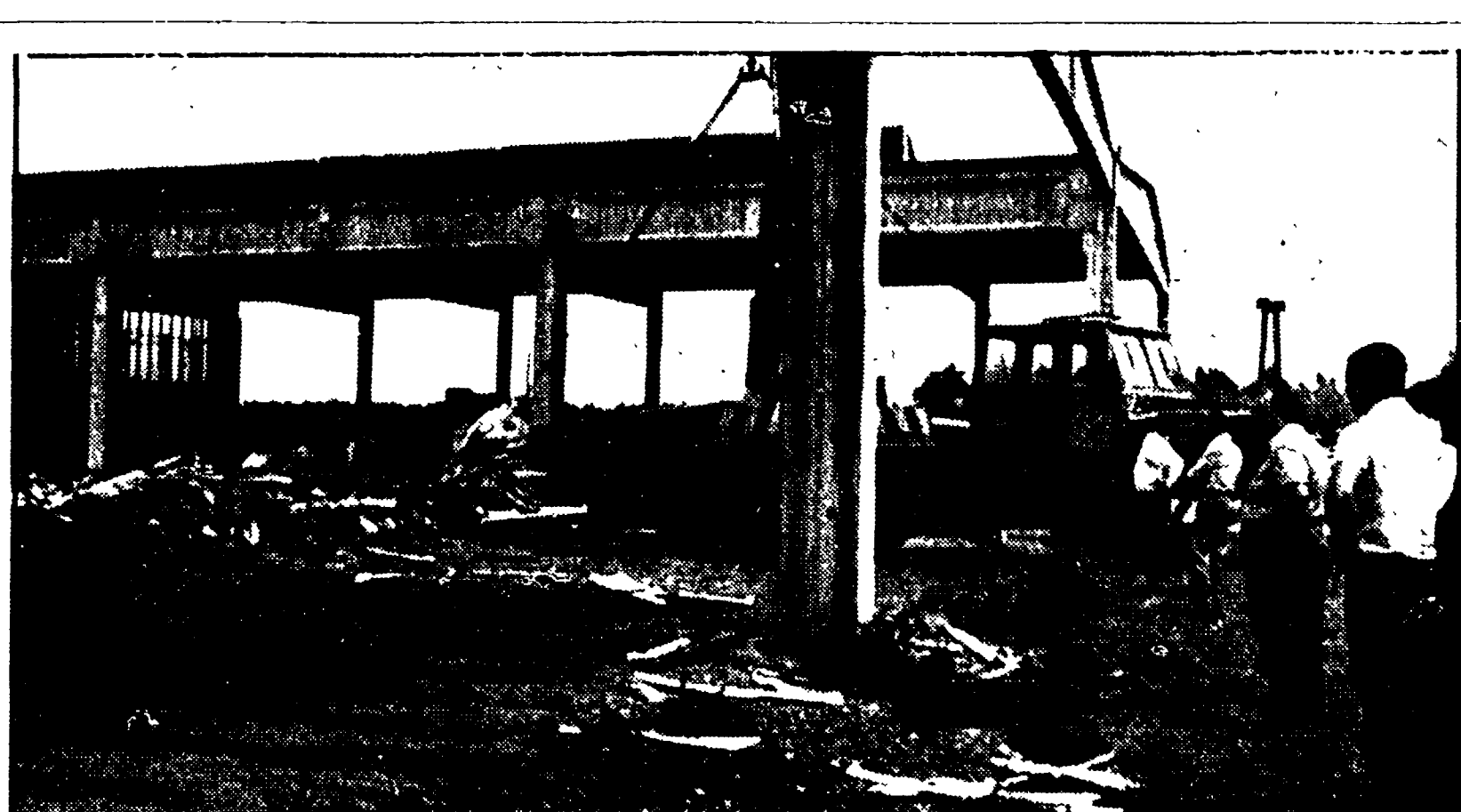
CROLLA UN CAPANNONE: UN MORTO. Il contitolare di una concessionaria per la Bassa Brianza di una ditta di acque minerali, Francesco Galimberti, è morto travolto nel crollo delle strutture in muratura di un capannone...
