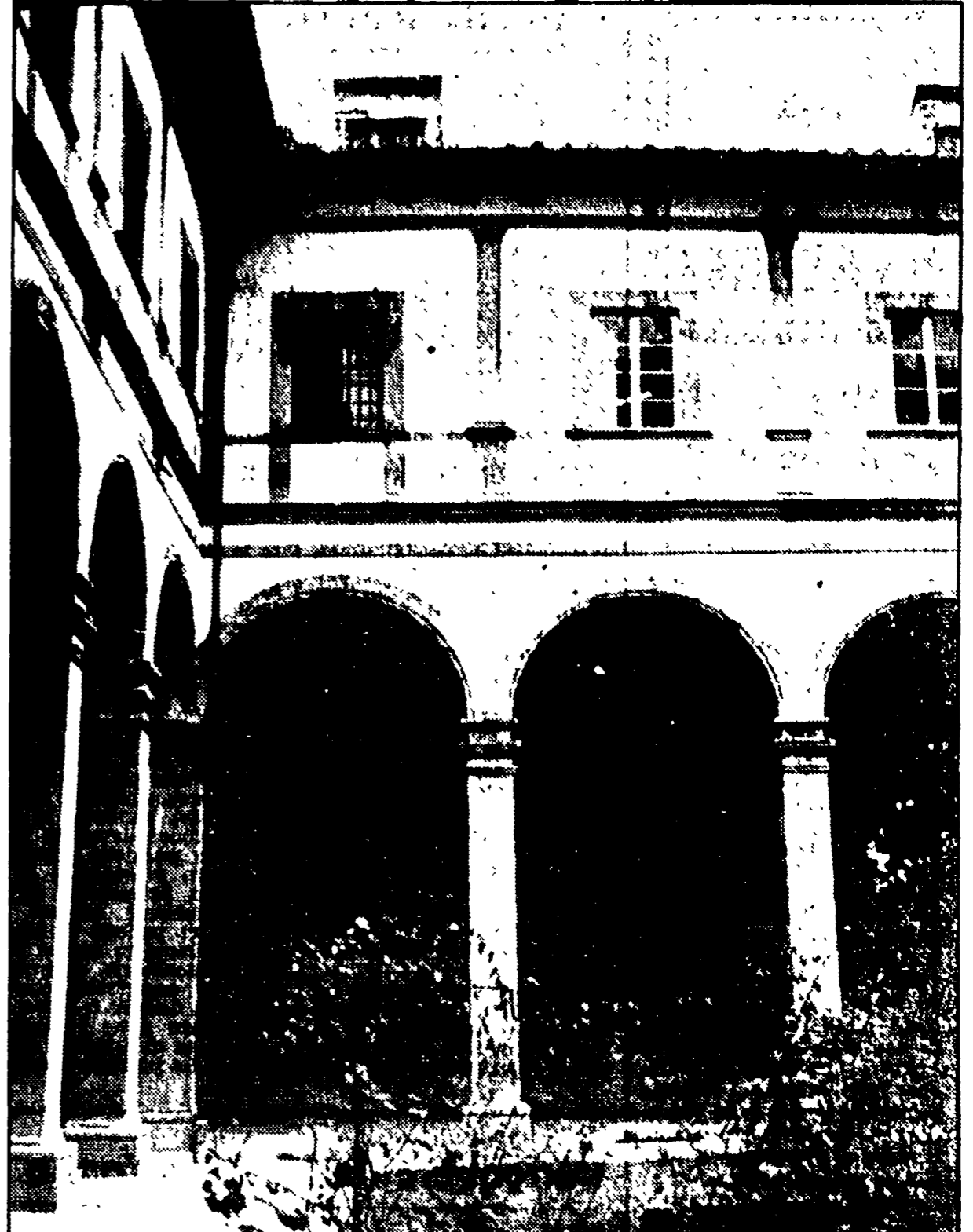
Il chiostro dopo i lavori di restauro e intonacatura
