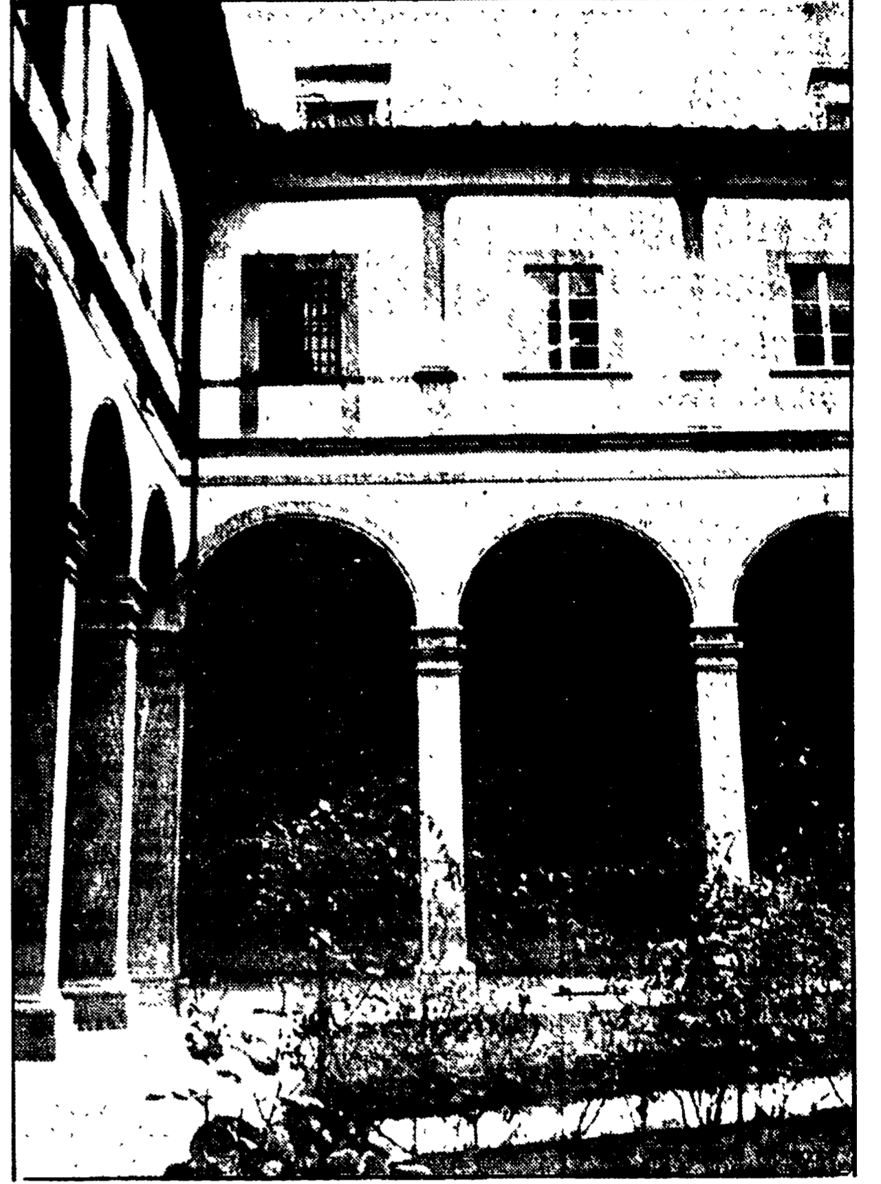
Il chiostro dopo i lavori di restauro e intonacatura
