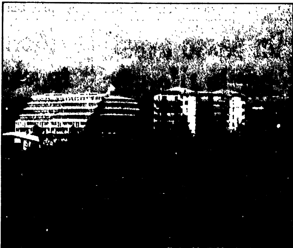
Il residence «contestado» all'Abetone dalla società GE.FI.RE. Tutta la metà di sinistra è stata costruita abusivamente
