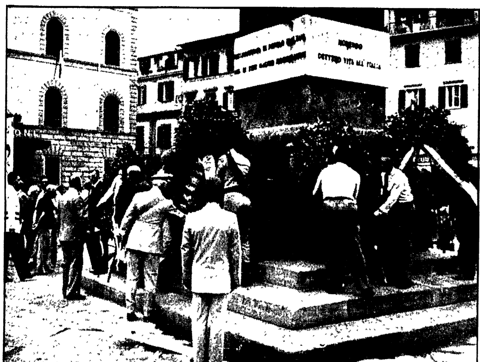
Deposizione di corone al monumento ai Caduti in piazza dell'Unità Italiana
