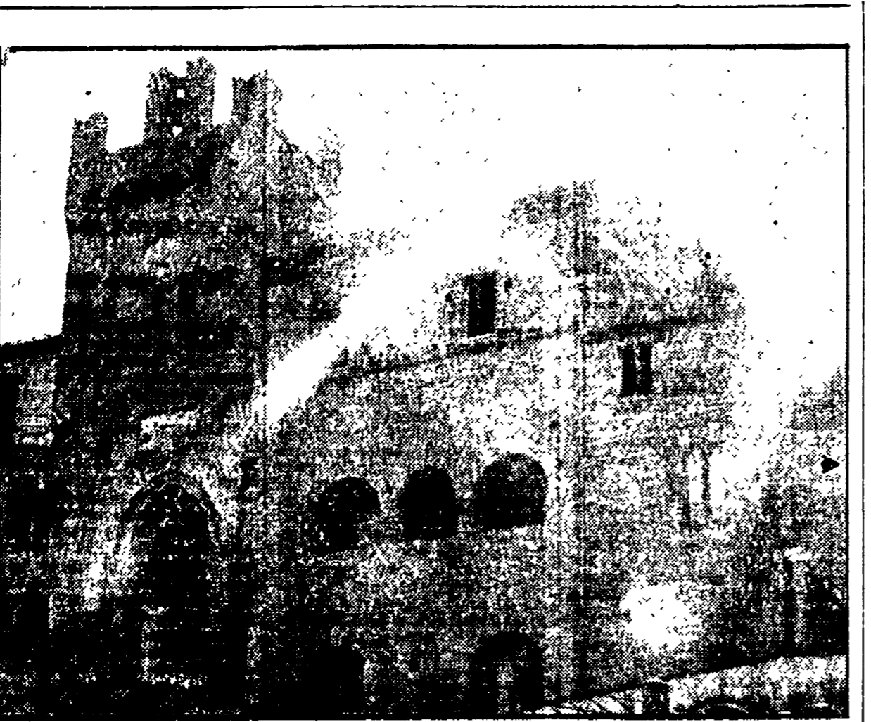
La stupenda facciata del Castello di Ponzano
