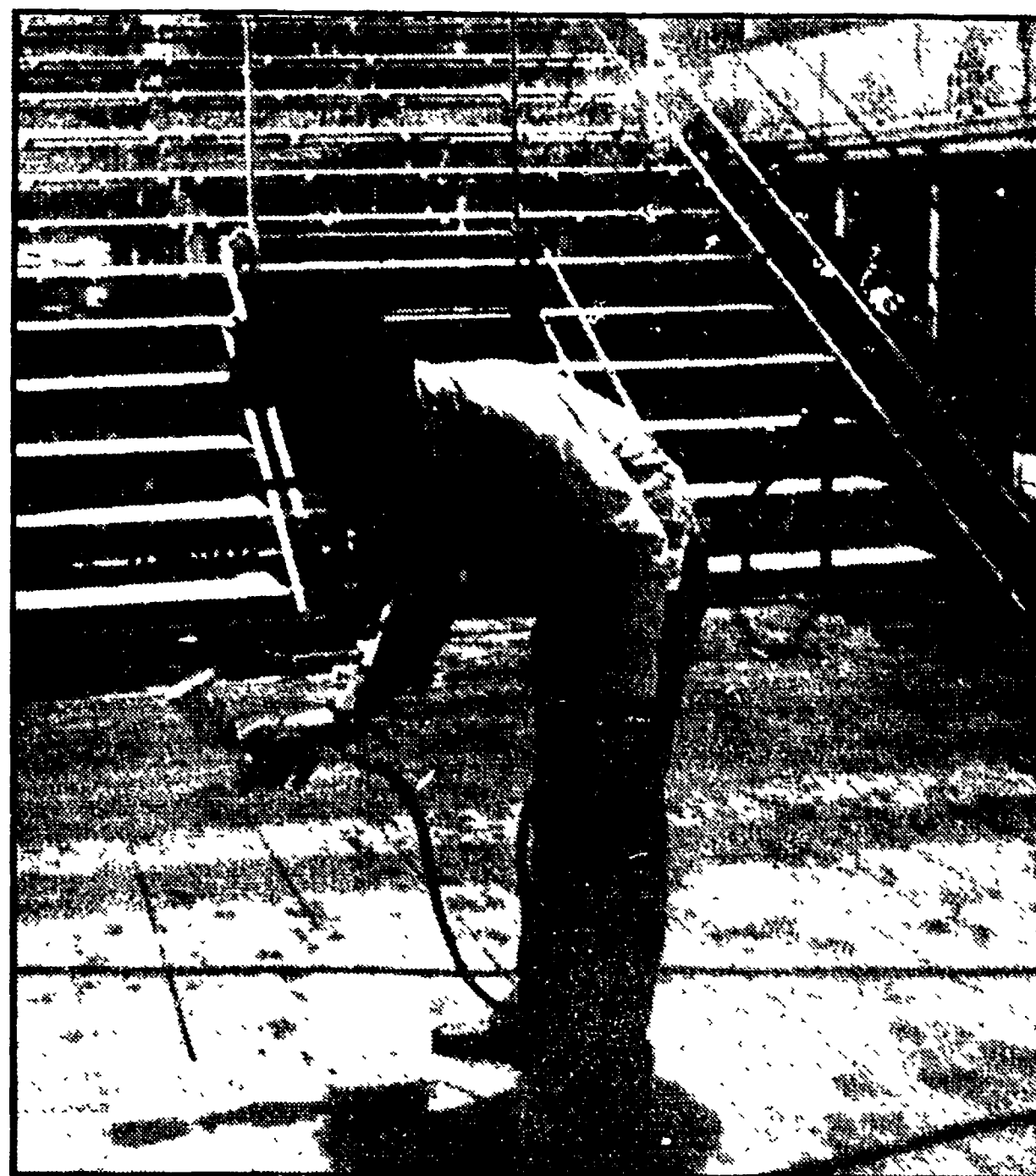
Si spruzza la speciale vernice «antincendio» che ha permesso la riapertura del teatro Goldoni
