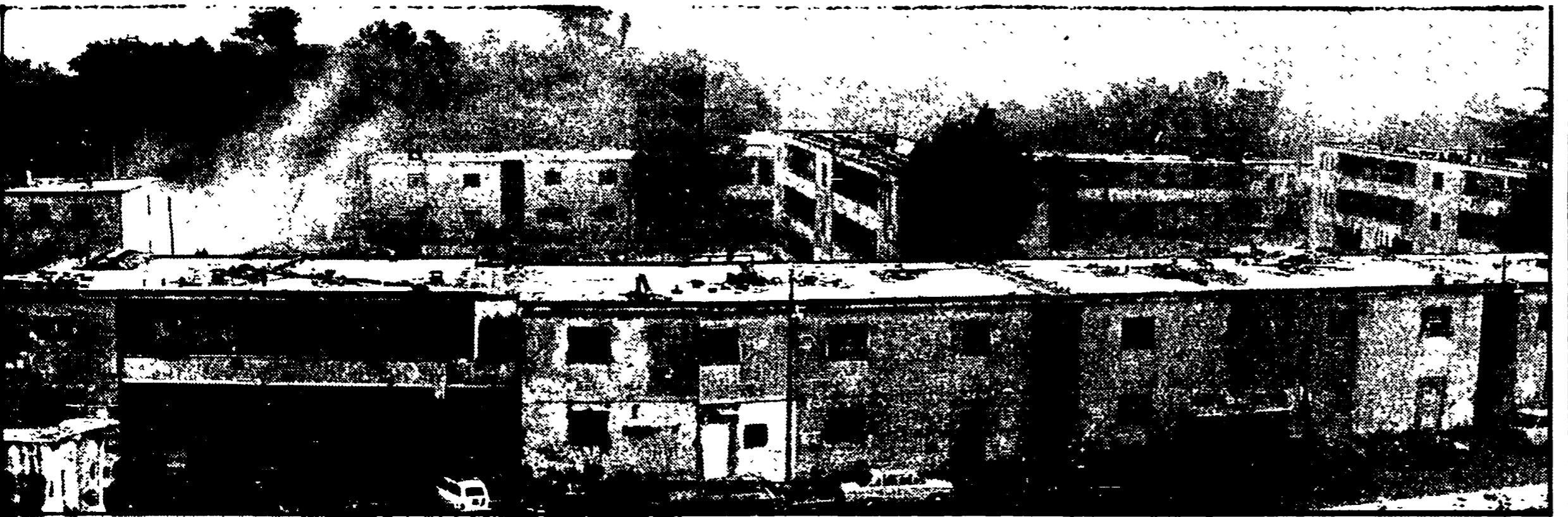
Una veduta di alcuni lotti di Tiburtino III. I fabbricati fatiscenti entro breve tempo saranno tutti abbattuti: al loro posto sorgerà un nuovo moderno complesso di edifici popolari
