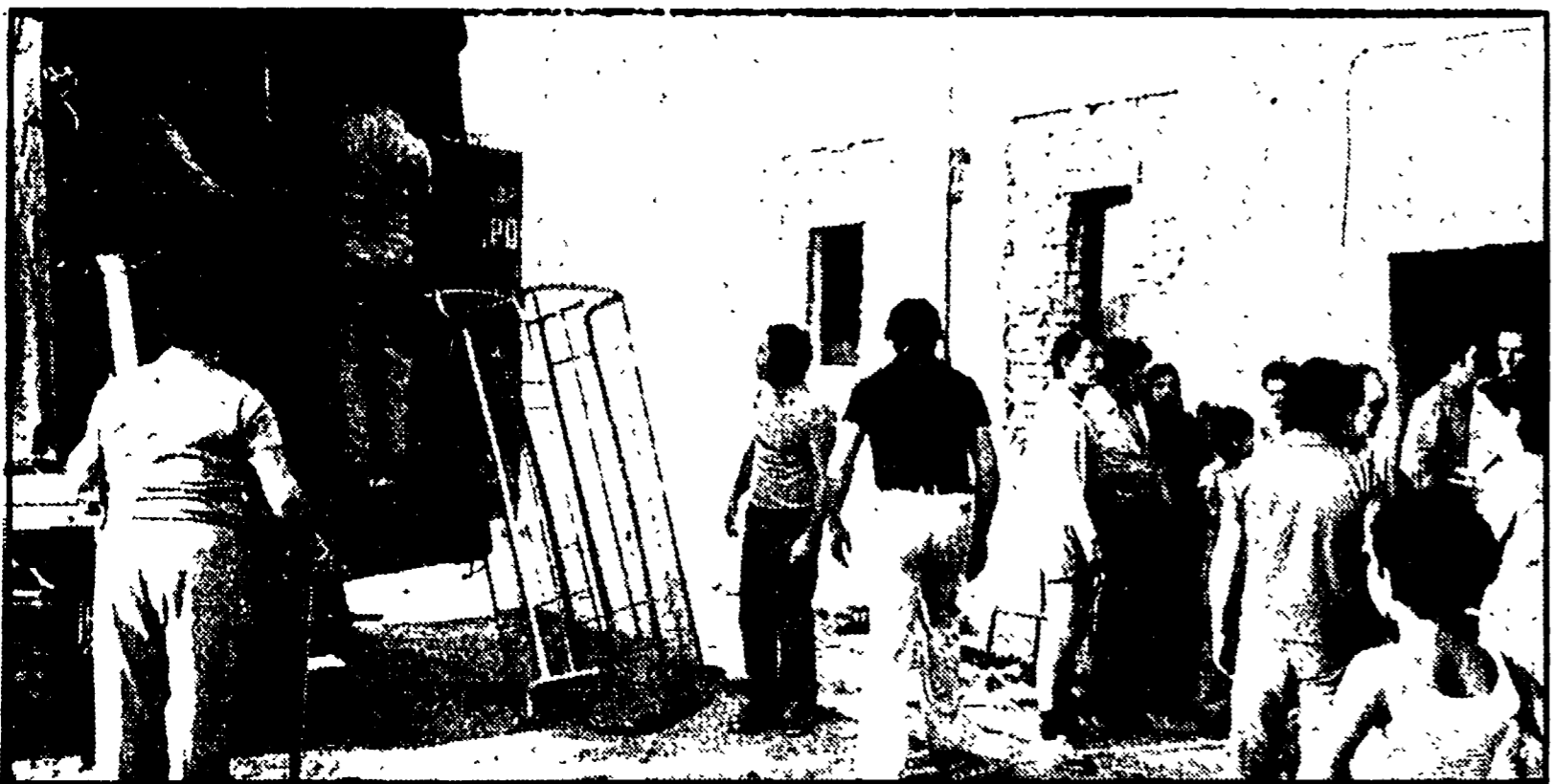
Una fase del trasloco delle famiglie che partono per Decima. A destra: la ruspa ha già smantellato le mura esterne di una costruzione del lotto numero 6
