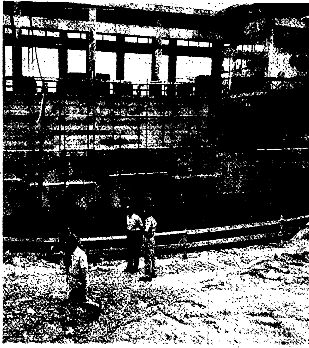
REGGIO EMILIA — Un aspetto del nuovo impianto idrovoro di Boretto. Queste dieci pompe, che pescano acqua dal Po a livelli bassissimi, hanno evitato gravi danni alle colture di una parte importante dell'agricoltura dell'Emilia e della Lombardia.
