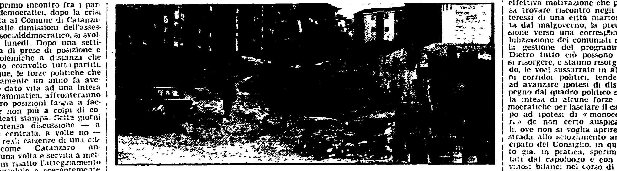
Un'immagine della degradazione urbanistica a Catanzaro
