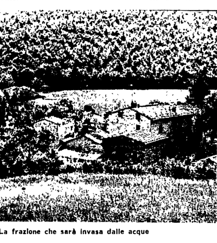
La frazione che sarà invasa dalle acque
