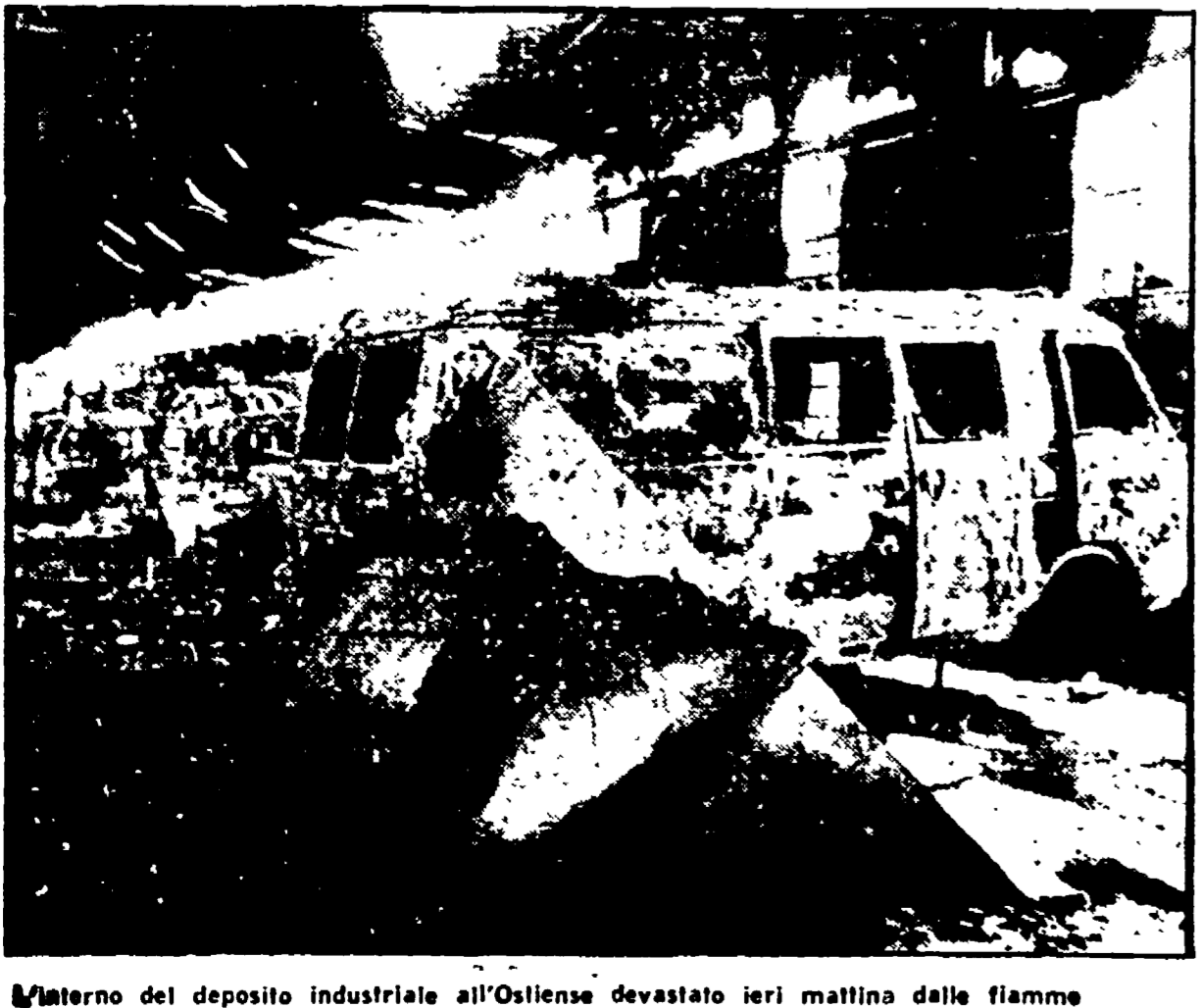
L'interno del deposito industriale all'Ostiense devastato ieri mattina dalle fiamme
