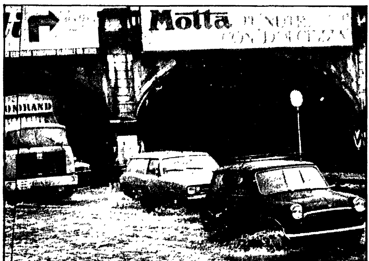
NUBIFRAGIO IN LOMBARDIA -- Il nubifragio che si è abbattuto ieri su tutta la Lombardia ha interessato anche Milano, dove ha piovuto ininterrottamente a dirotto dal primo mattino. L'acqua ha allagato numerosi scantinati. I vigili del fuoco hanno ricevuto centinaia di chiamate anche da parte di automobili rimasti bloccati da allagamenti. Il traffico è letteralmente «dipizzato» e il centro di Milano è rimasto per molte ore intasato di autobotoli. NELLA FOTO: una strada allagata nei pressi dell'aeroporto di Linate.
