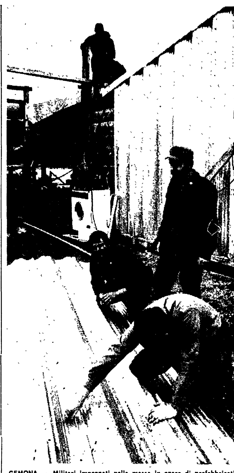
Sergio Miravalle GEMONA — Militari impegnati nella messa in opera di prefabbricati.
