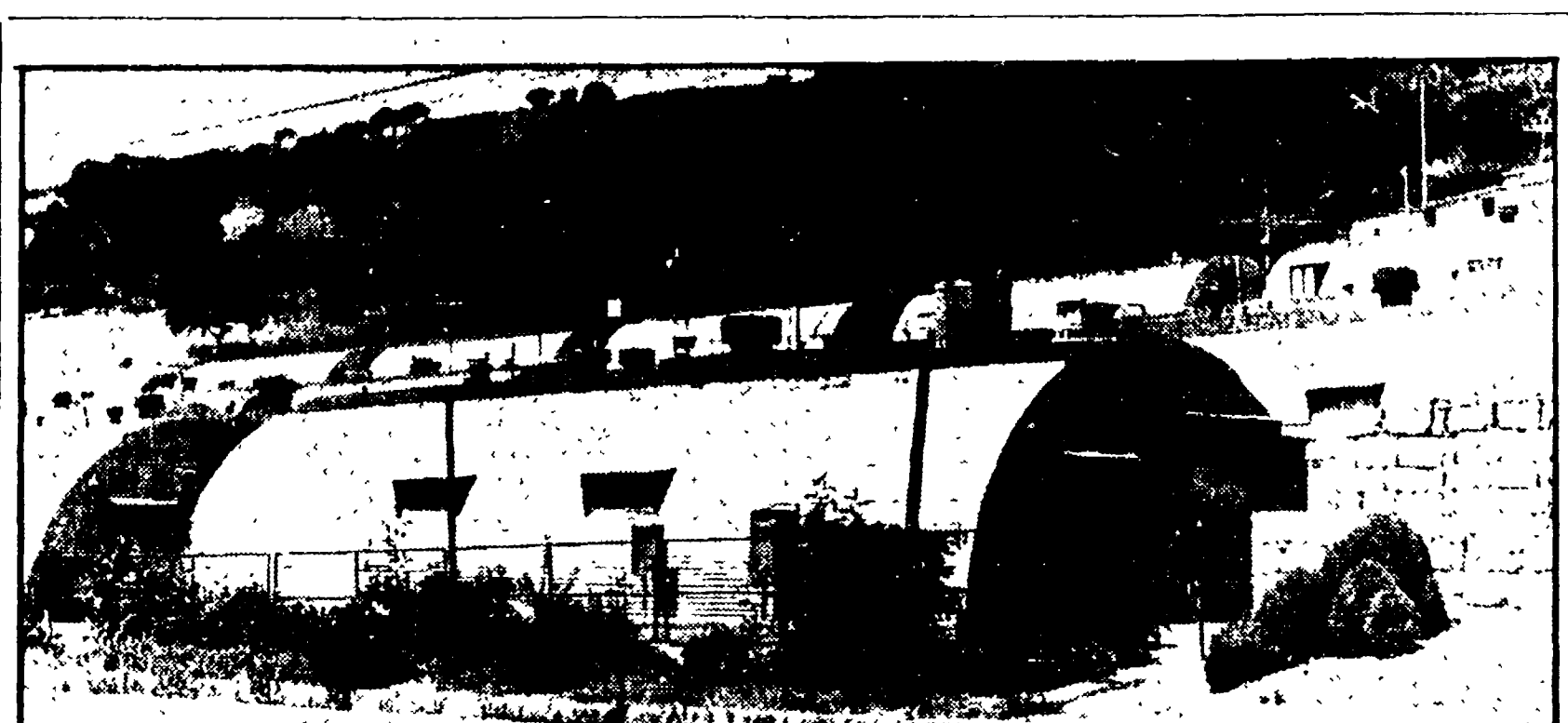
Le baracche del Belice (foto Marina Natoli)
