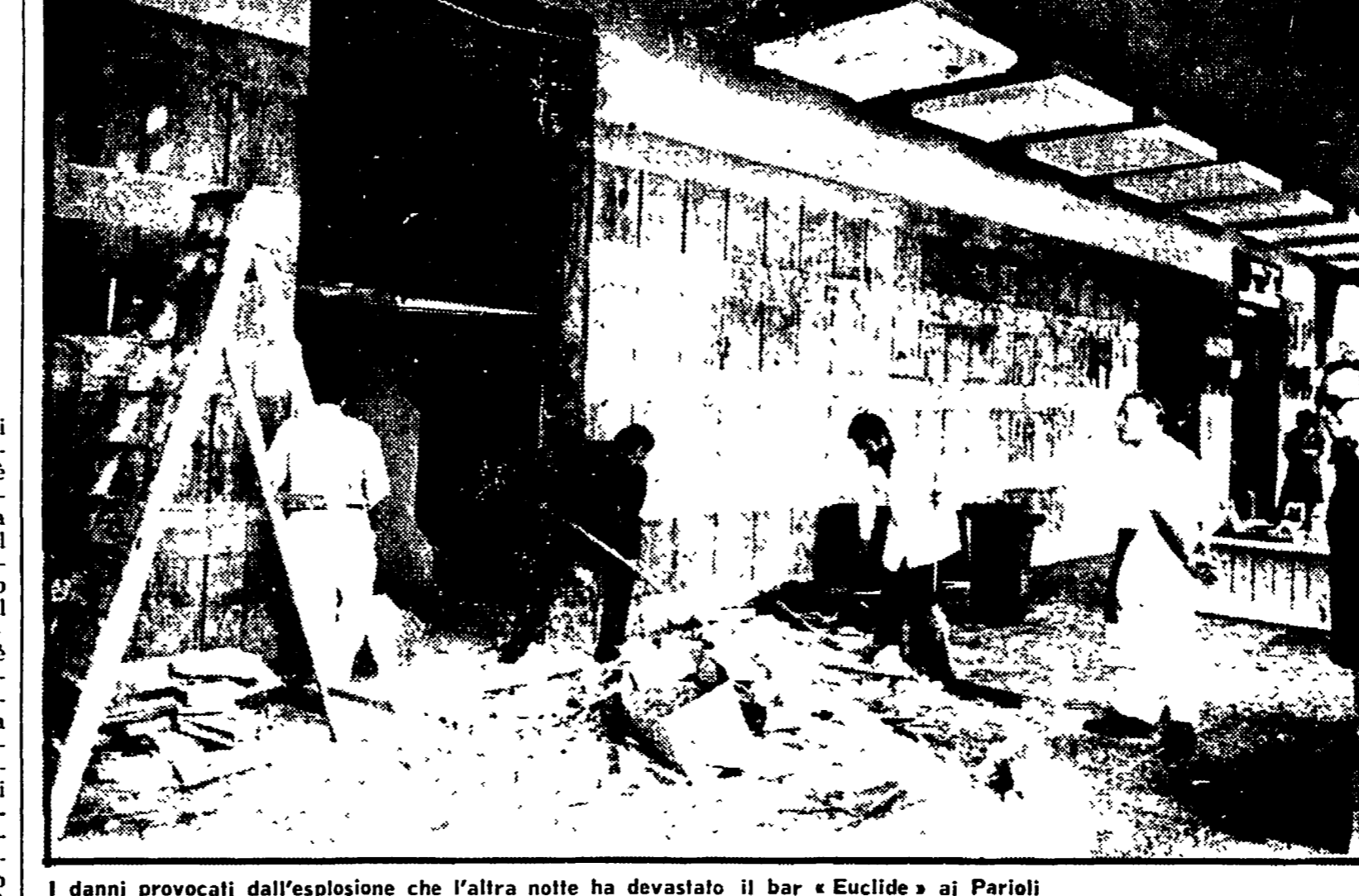
I danni provocati dall'esplosione che l'altra notte ha devastato il bar « Euclide » ai Parioli
