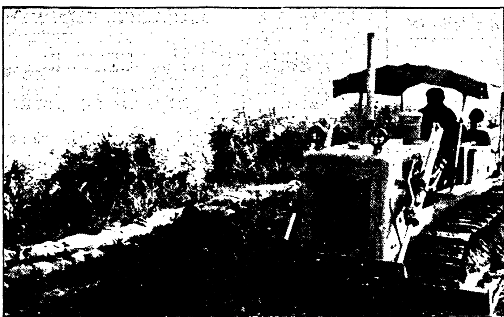
GORO (Ferrara) - Si lavora a rinforzare gli argini del Po
