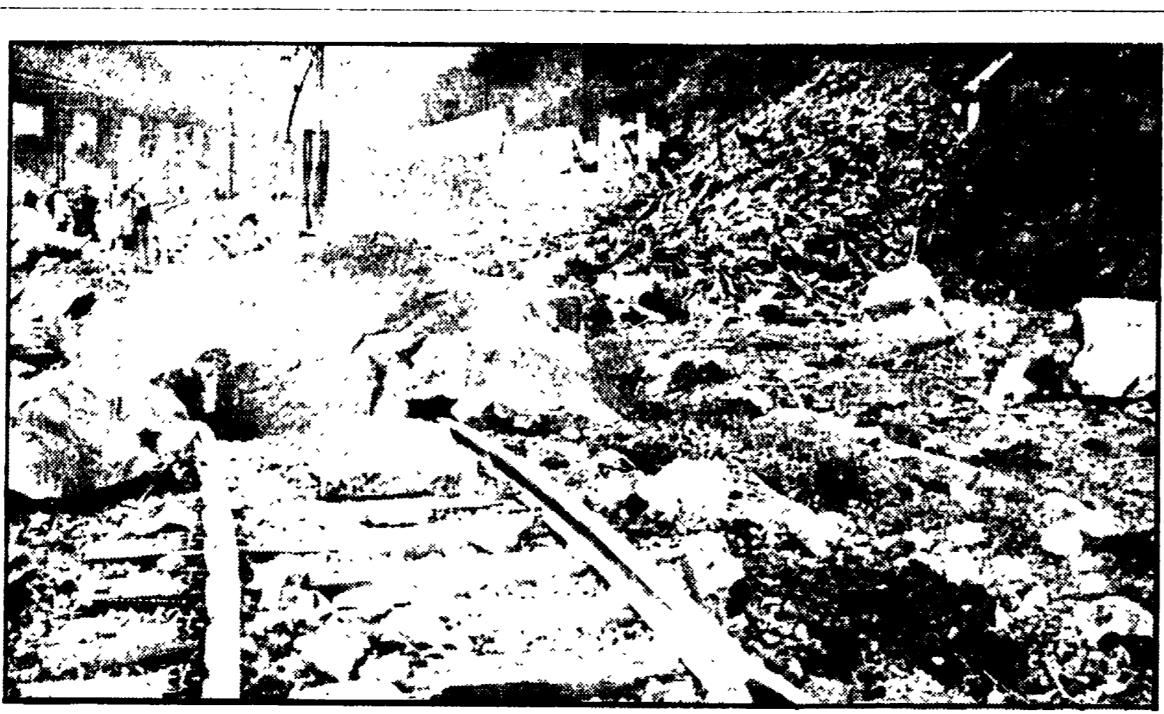
BOLZANO — La ferrovia del Brennero interrotta dalla frana
