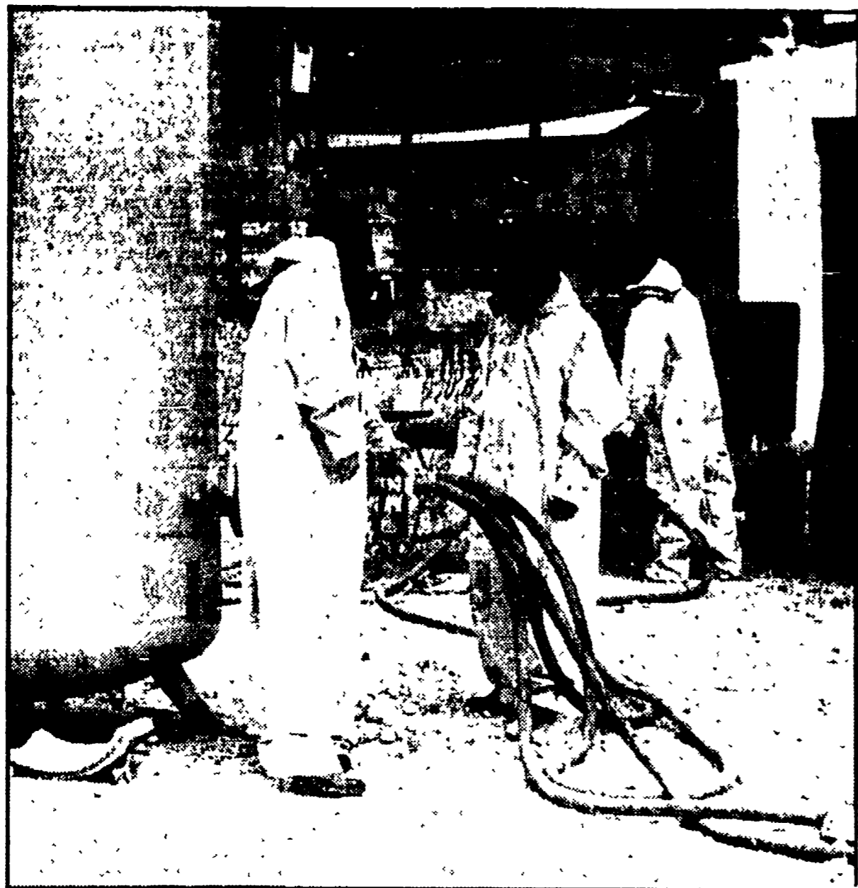
Tecnici provvedono ad operazioni di bonifica all'interno dello stabilimento dell'ANIC
