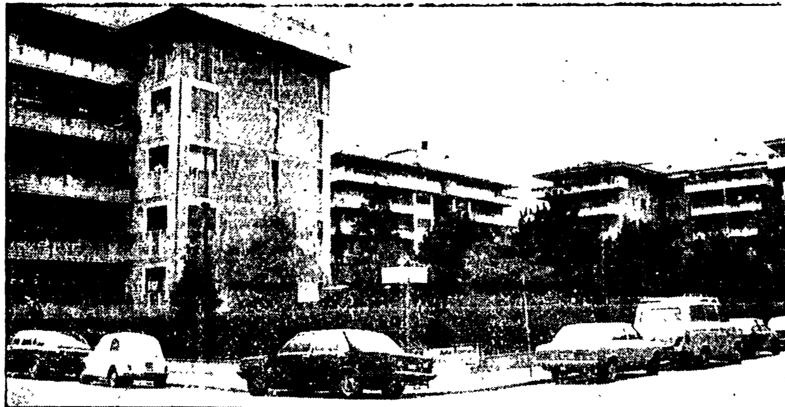
I nuovi complessi edilizi sull'area ex Whurrer
