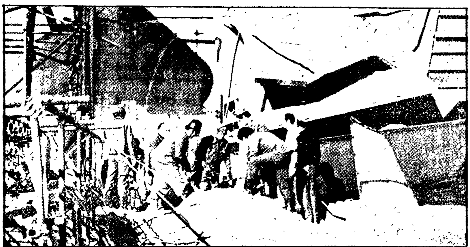
NAPOLI - Il contenitore di sabbia precipitato che ha travolto e ucciso i due operai
