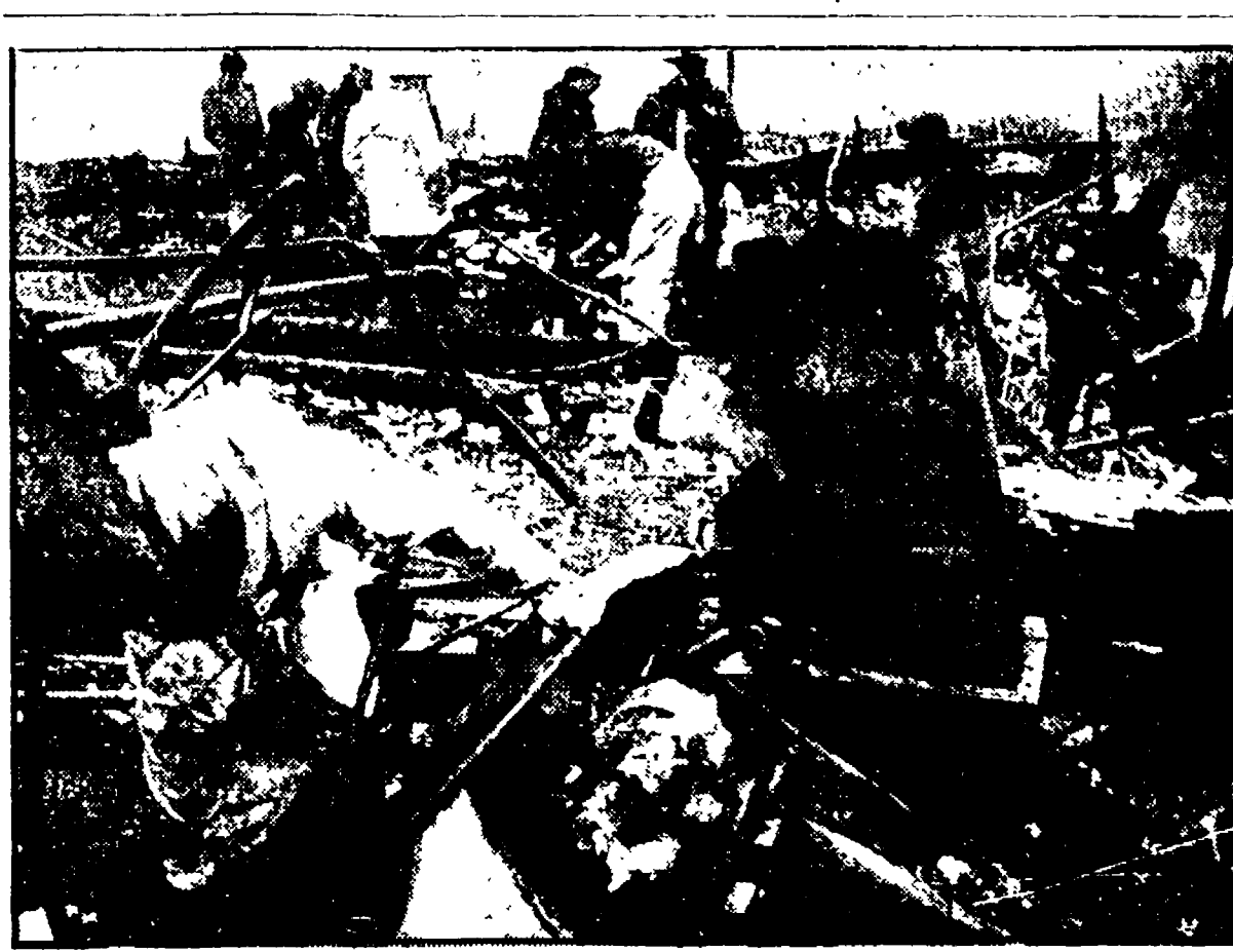
IL CIRCOLO DEVASTATO. Esperti ed artigiani americani e tedeschi-occidentali al lavoro tra le macerie del Circolo ufficiali della base aerea statunitense di Francoforte...
