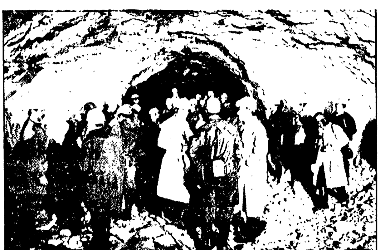
COMPLETATO TRAFORO SAN GOTTARDO. Operai italiani, spagnoli, jugoslavi e greci con i tecnici svizzeri hanno festeggiato l'esplosione dell'ultima mina che ha permesso di completare il traforo della più lunga galleria stradale del mondo...
