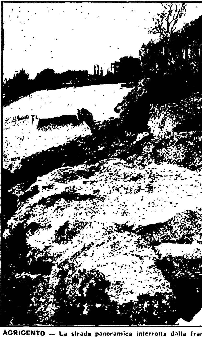
AGRIGENTO — La strada panoramica interrotta dalla frana sotto il tempio di Giunone
