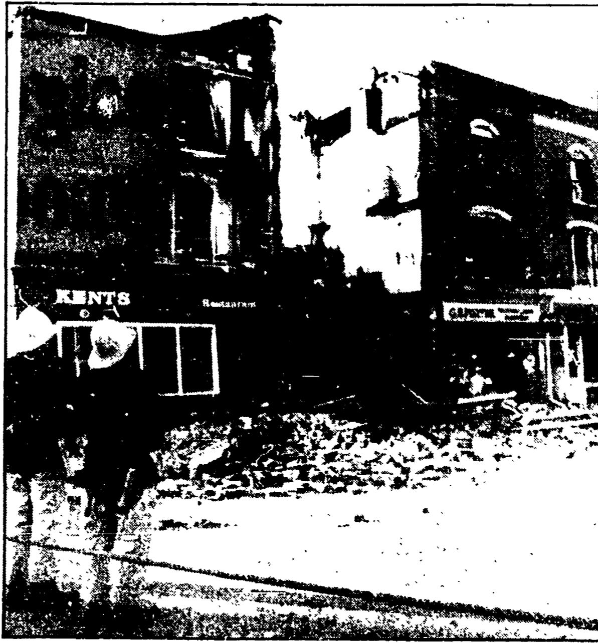
NON E' UN ATTENTATO Una esplosione ha devastato un edificio di Beckenham (contea di Kent, a sud di Londra) dove aveva sede fra l'altro una grossa lavanderia. Una persona è rimasta seriamente ferita ed altre due hanno riportato stato di shock. Dapprima si è pensato ad un attentato, ma secondo successivi accertamenti dei vigili del fuoco si sarebbe trattato di una fuga di gas. NELLA FOTO: gli effetti della esplosione
