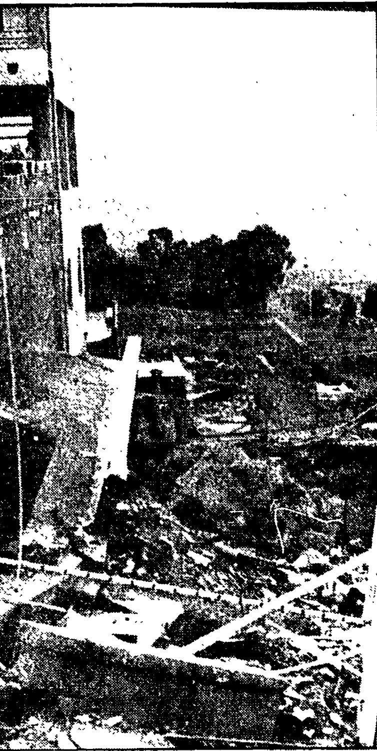
ALTRA FRANA A CALTANISSETTA. A Caltanissetta si è messa in movimento un'altra frana che ha già ucciso sei danni al centro della città. In un documento i geologi hanno accusato gli organismi comunali di non aver predisposto, con il piano regolatore, un serio studio del sottosuolo...
