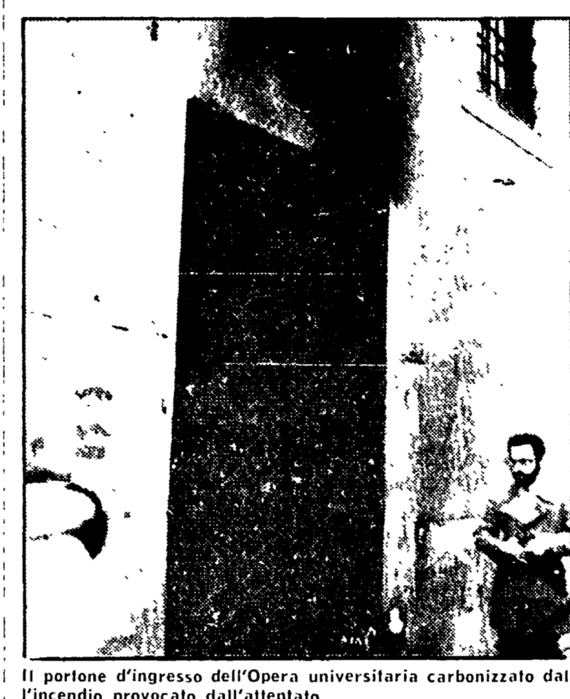
Il portone d'ingresso dell'Opera universitaria carbonizzata dal incendio provocato dall'attentato
