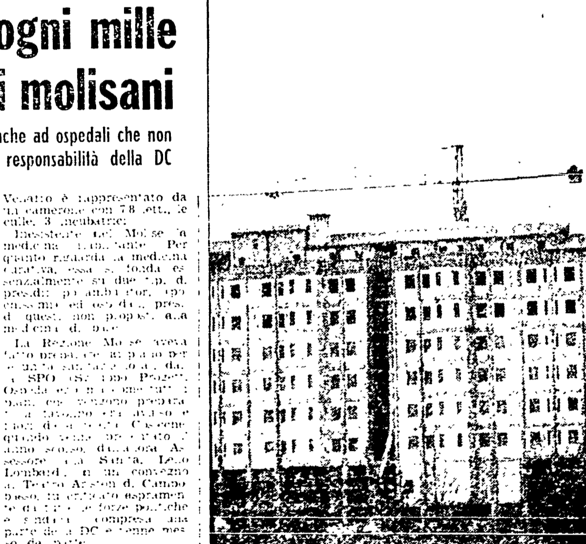
Una gru spunta dall'edificio del Cardarelli di Campobasso. I lavori per il suo ampliamento, avviati nel 1962, non sono stati mai ultimati
