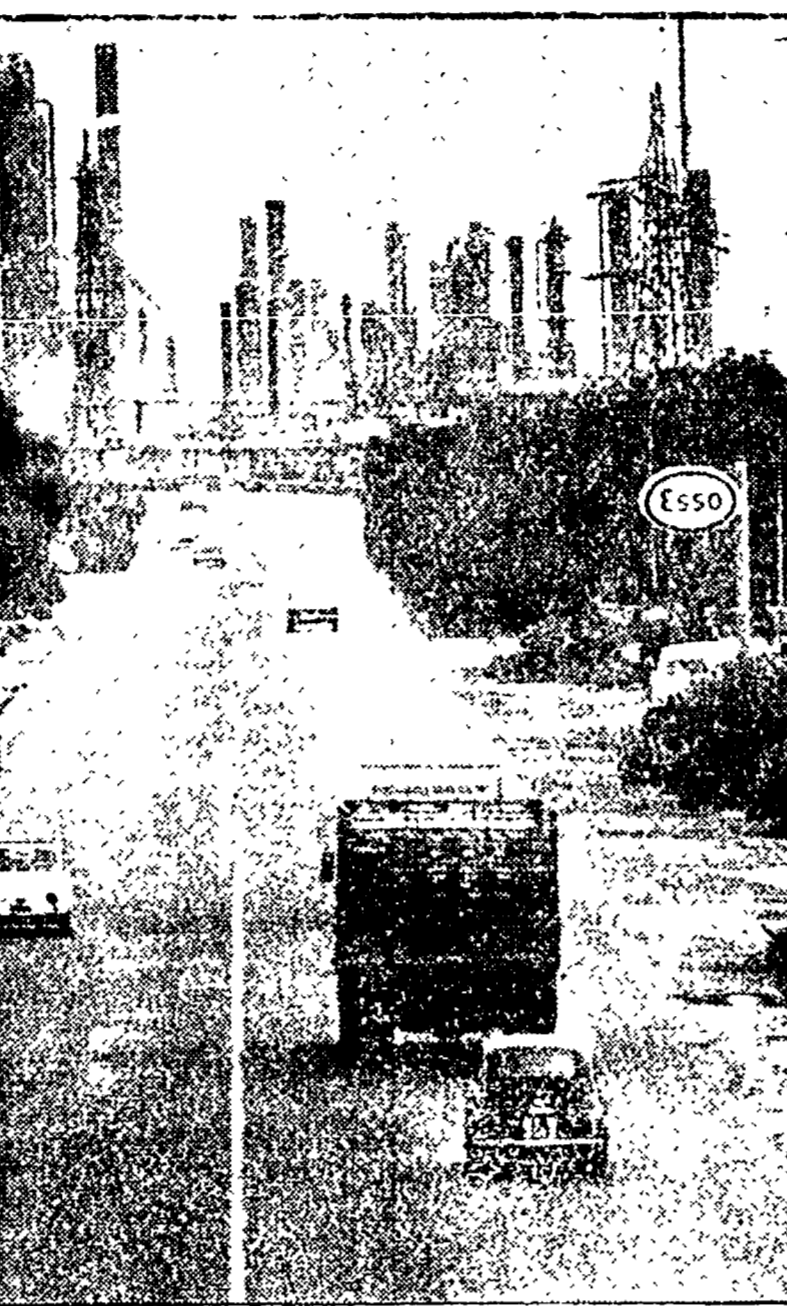
Una parziale veduta del polo chimico di Priolo. Come si vede il passaggio, per chilometri e chilometri, è fatto di tubazioni, oleodotti, reti stradali, pontili. Resta poi la minaccia dell'inquinamento atmosferico
